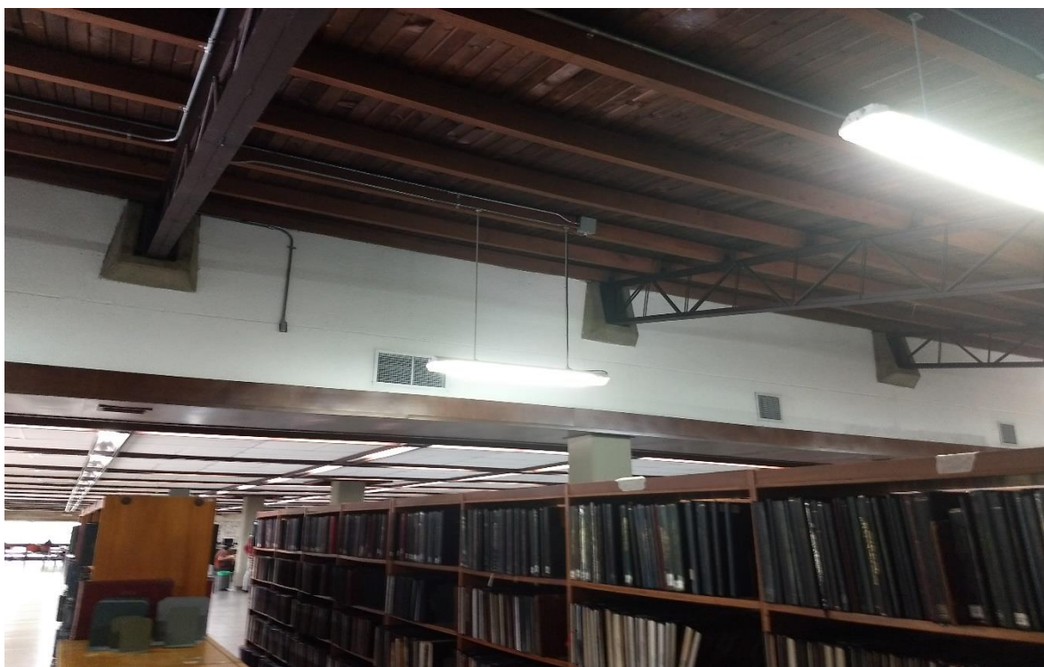
FIGURA 9. LUMINARIA FLUORESCENTE DE 2x54 W EXISTENTE EN TERCER PISO DE LA BIBLIOTECA
