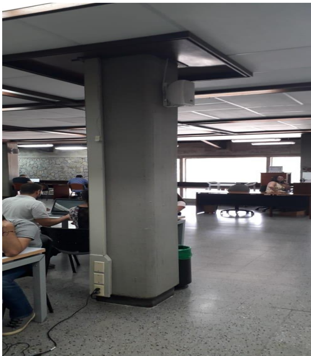
FIGURA 6. CANALETA Y CONEXIONES EXISTENTES EN COLUMNAS
