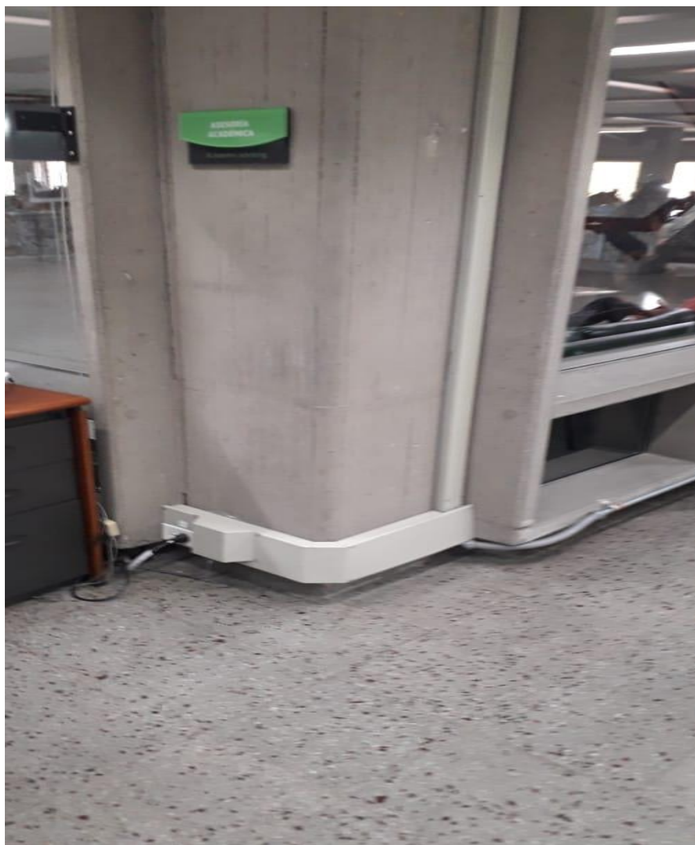
FIGURA 7. CANALETA Y CONEXIONES EXISTENTES EN COLUMNA
