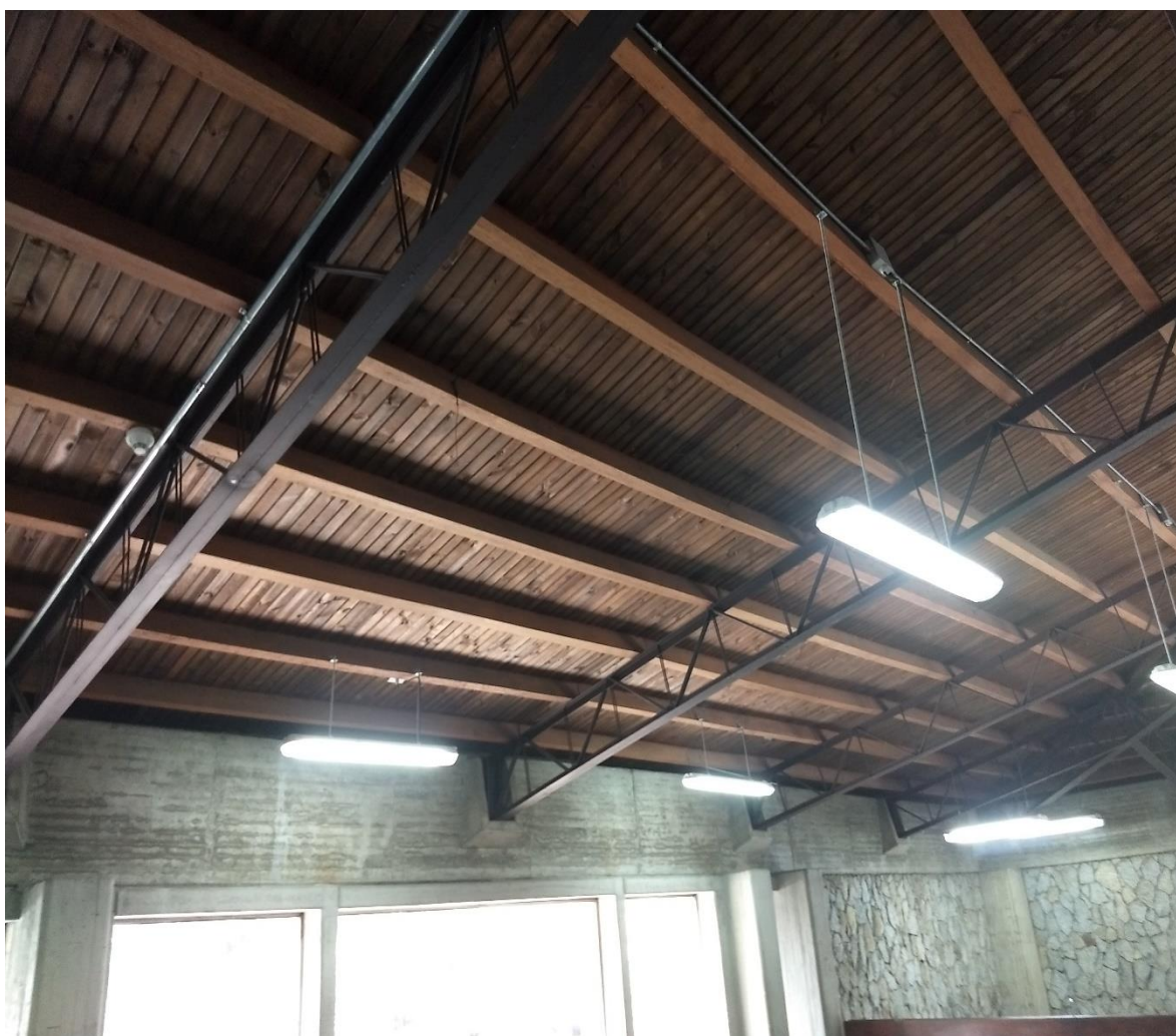
FIGURA 8. LUMINARIA FLUORESCENTE DE 2x54 W EXISTENTE EN TERCER PISO DE LA BIBLIOTECA
